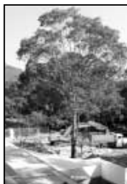
UniBar Construction Site
